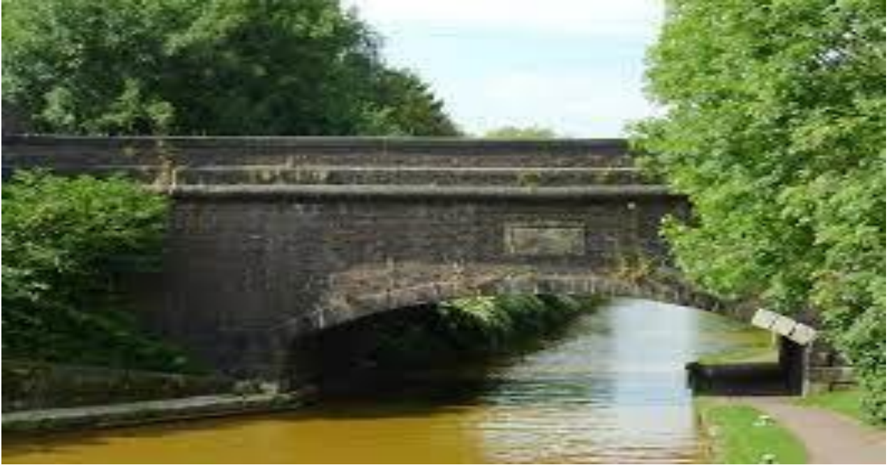
Tunnels and culvers. सुरंगें और पुलिया
